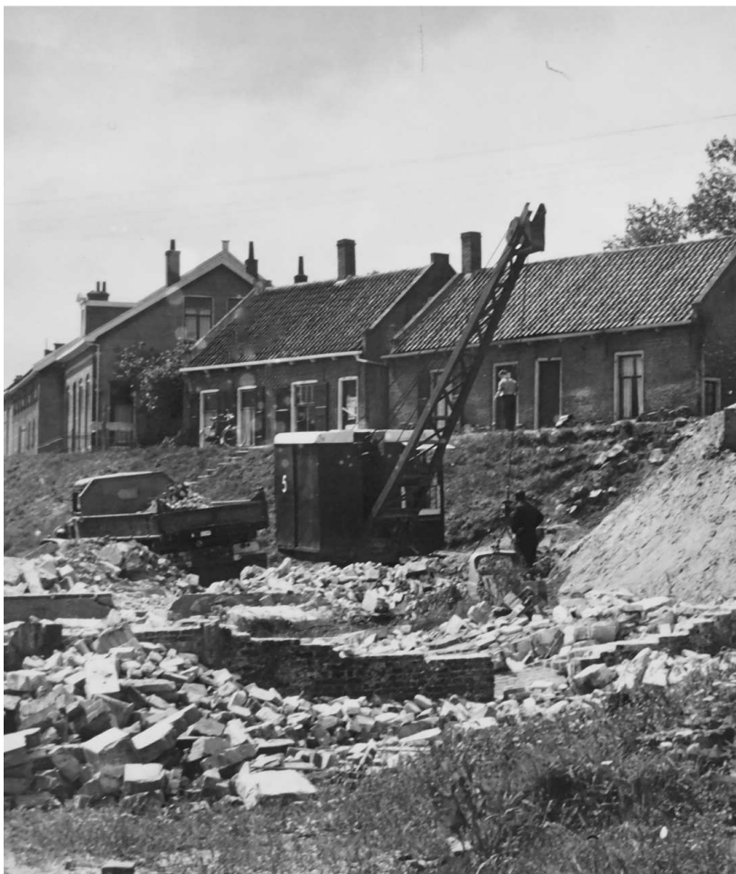
*Sloopwerkzaamheden in 's-Gravendeel in 1959. Van der Linden (VDL) aan het werk met een GMC en dragline.
