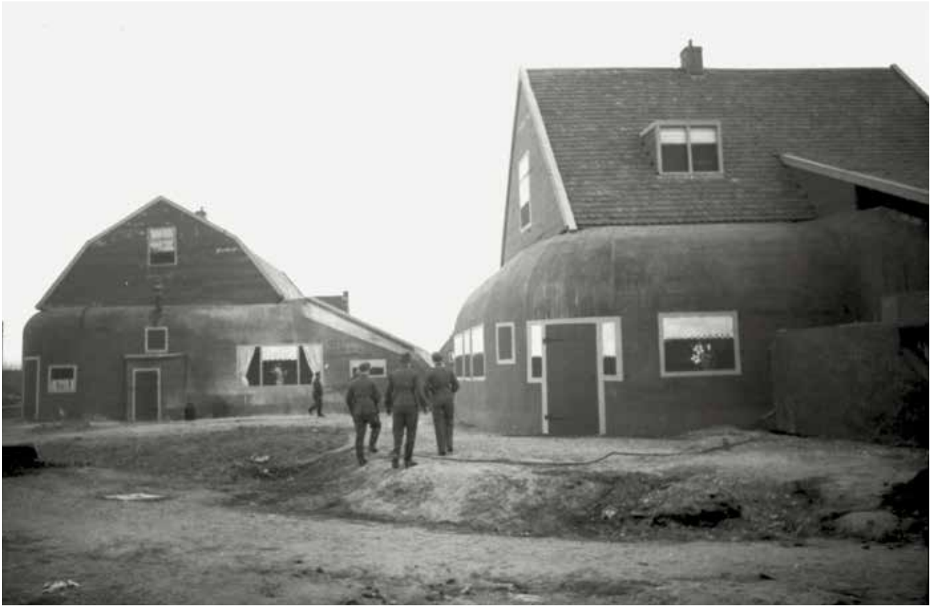
→ De bunkers van een bataljonshoofdkwartier nabij 's-Gravenzande waren gecamoufleerd als woonhuizen met pannendak en geschilderde ramen met bloemen en gordijnen.
