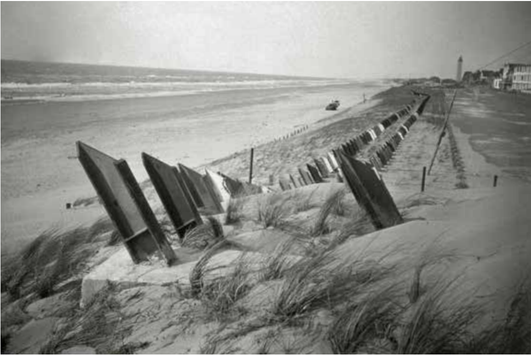
↑ Stalen I-profielen in een betonnen fundament als antitankversperring op de boulevard van Noordwijk.
