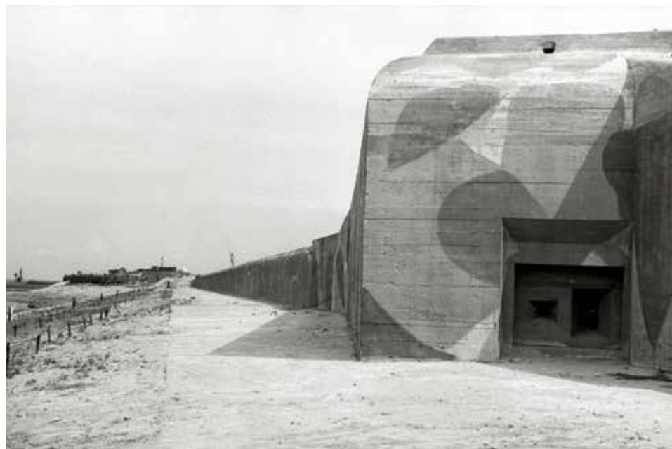
↖ Verstärkt feldmäßiger Pak-Unterstellraum (type 5b) met naastgelegen woonbarak. Ertussen een hondenhok met waterbak. Pak staat voor Panzerabwehrkanone.
