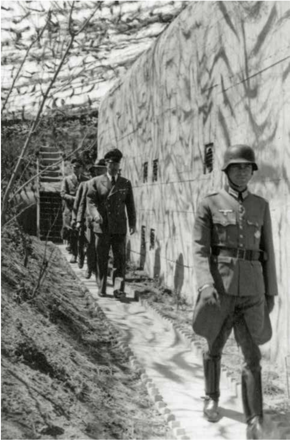
↓ Arthur Seyss-Inquart tijdens een inspectie van batterij Kernwerk in Hoek van Holland. De schaduw van camouflagenetten is zichtbaar op de muur van de bunker (type M176).
