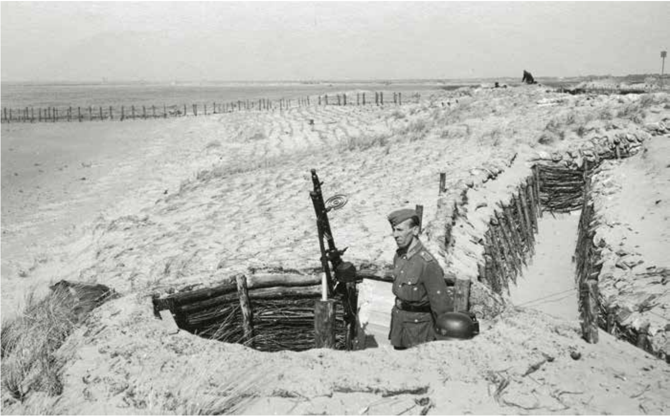
→ Een loopgraaf en mitrailleurpost in Hoek van Holland, gemaakt van hout en gevlochten takken, in het Duits Faschinen genoemd. Vaak werden hiervoor wilgentakken gebruikt. Het mulle duinzand werd zoveel mogelijk vastgehouden door aanplant en graszoden, zoals op de voorgrond te zien.
